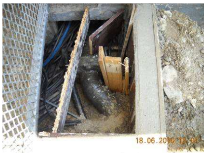
Réparation conduite eau de service
